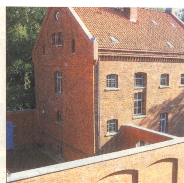
Zwei Jahre dauerten die Sanierungs- und Neubauarbeiten. Gestern wurde das ehemalige Gefängnis als „Alkatrass“ präsentiert.
